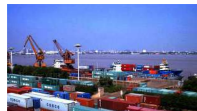
Saigon Premier Container Terminal, Vietnam
